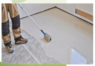
пузырьков Для удаления воздуха необходимо тщательно покрытия обработать поверхность игольчатым Эксплуатация валиком. покрытия возможна не раньше, чем через 24 часа после нанесения при температуре помещении не менее (≥) 20°C.Температура материала от +15°C до применения +25°C.
